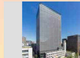
川崎市新本庁舎超高層棟新築工事
