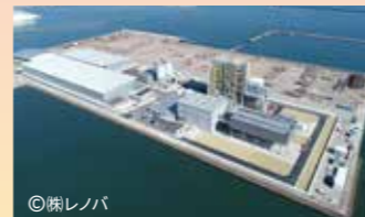
徳島津田バイオマス発電所
