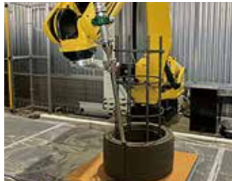
鉄筋近傍での施工状況
