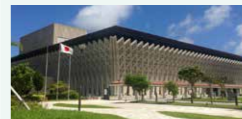
国立劇場おきなわ 大成建設元請。PCa製作を当社が担当
