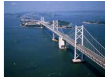
1985 南北備讃瀬戸大橋(下部工、北工区)
