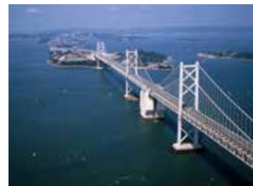
1985 南北備讃瀬戸大橋(下部工、北工区)
