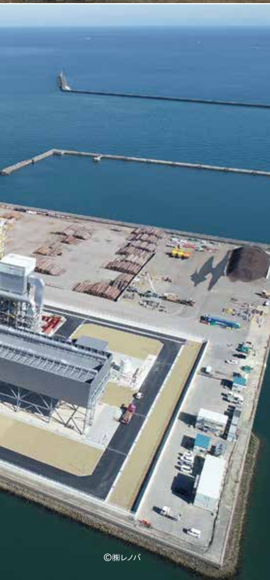
令和2年度木与防災木与 第3トンネル工事(山口県) ロックボルト打設専用機「BOLTINGER」の適用により、トンネル工事の安全性・生産性向上に貢献
