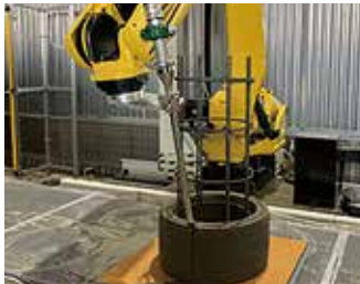
鉄筋近傍での施工状況
