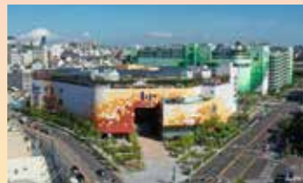
（仮称）三井ショッピングパーク ららぽーと台中新築工事
