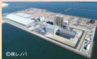
徳島津田バイオマス発電所
