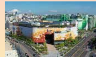
(仮称)三井ショッピングパーク ららぽーと台中新築工事
