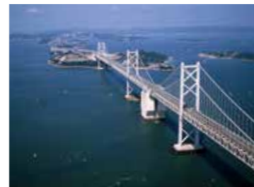
1985 南北備讃瀬戸大橋(下部工、北工区)
